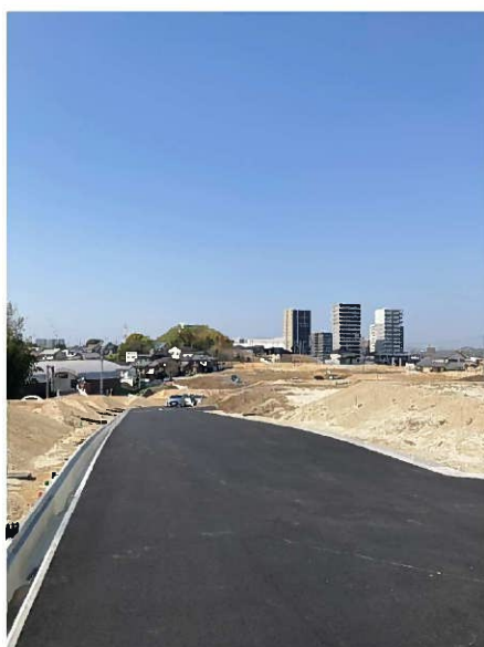
【地区南西部から北側方面】
